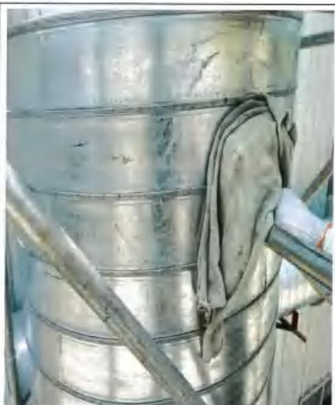
图 9.4 浸漆及烘干工序废气处理后检测口 ©Q4
