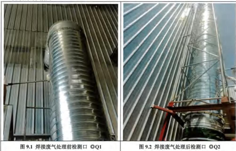
图 9.1 焊接废气处理前检测口 ◎Q1
