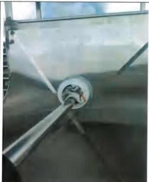
图 9.8 厨房油烟废气处理后检测口 ©Q6
